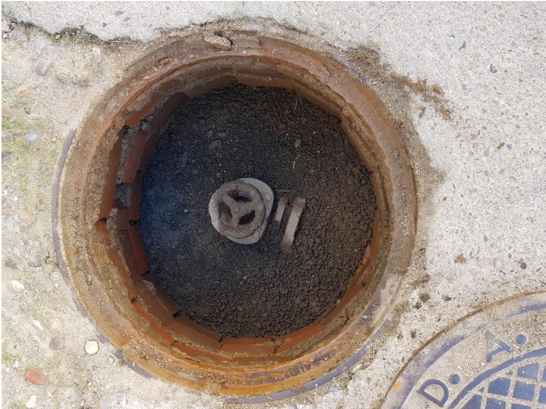
Llave de corte a renovar
