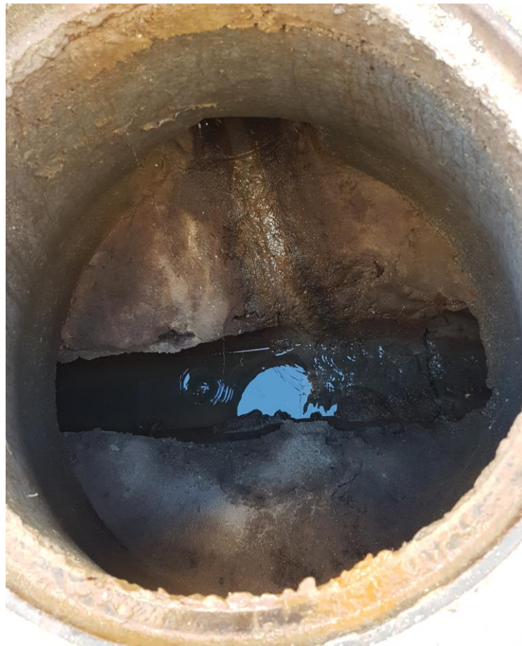
Pozo de saneamiento a renovar
